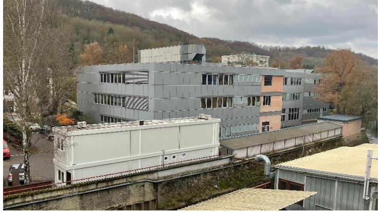
d'Gebäier B-C-D mat de Containeren
